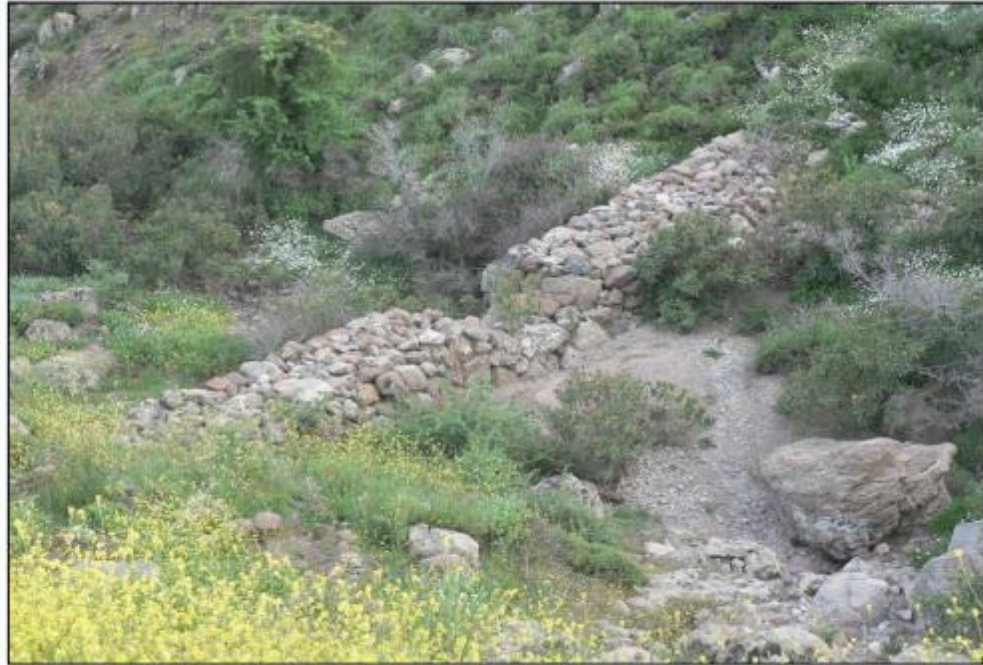
RESİM 8. SEL YATAĞINDA KURU DUVAR EŞİK. GELEN MATERYAL DOLDURMUŞ VE BİTKİLER YETİŞMİŞ, KAPLAMIS.
