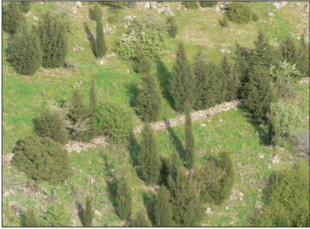
RESİM 10. TOPRAĞI TAŞINMIŞ KAYALIK ARAZİDE SELİ ÖNLEMELİK İÇİN KURU DUVAR İLE SEKİLEME.
