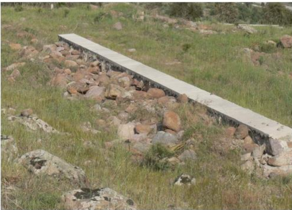
RESİM 10. TOPRAĞI TAŞINMIŞ KAYALIK ARAZİDE SELİ ÖNLEMELİK İÇİN KURU DUVAR İLE SEKİLEME.
