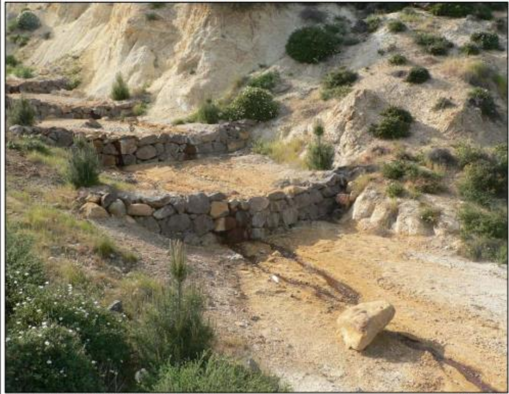
RESİM 7. SEL DERESİNE YAPILMIŞ KURU TAŞ EŞİKLER
